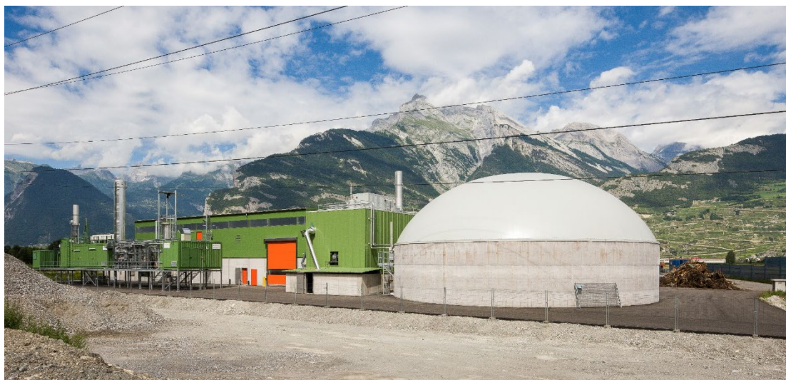
Figura 1 Esempio di impianto industriale a biogas in Vallese (Vetroz)
