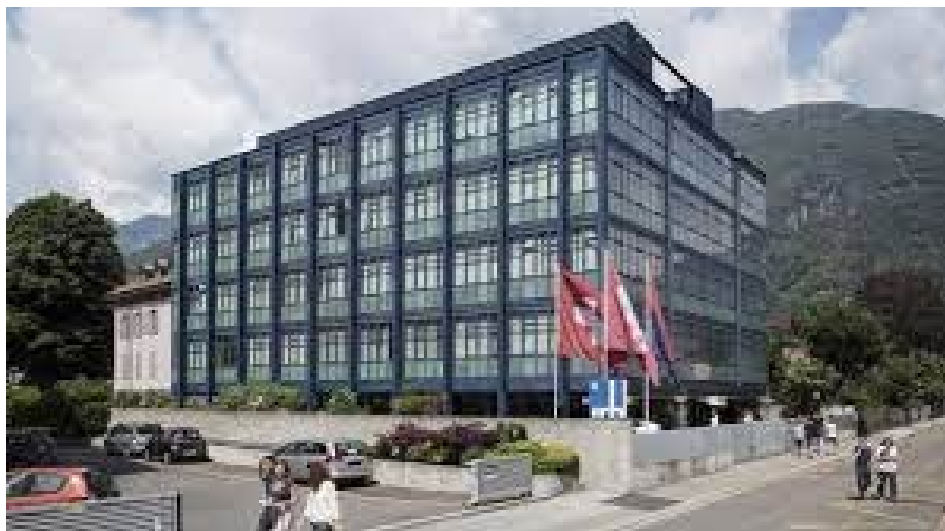
La sede dell'IRB in Via Vela 6.
