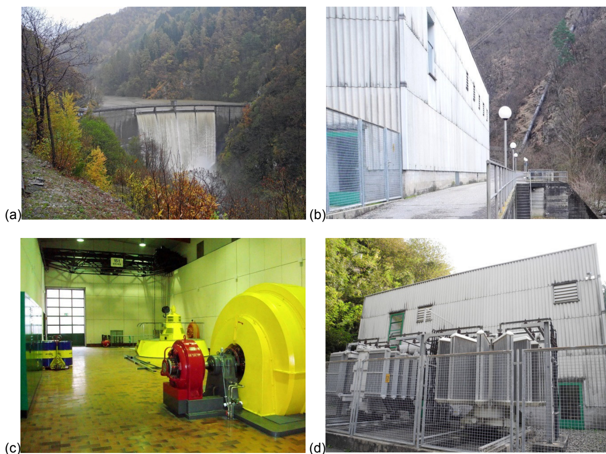
Fig. 1 Componenti principali dell'impianto Morobbia; (a) diga di Carmena; (b) arrivo della condotta forzata alla centrale Morobbia; (c); vista dell'interno della centrale, in primo piano il gruppo Pelton, in secondo piano il gruppo Francis; (d) gruppo di trasformatori.
