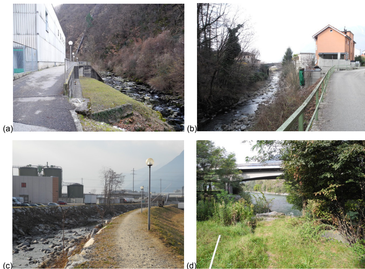
Fig. 7 Condotta di restituzione. (a) centrale Giubiasco, la zona la centrale e il t. Morobbia dove verrà costruita la vasca di raccolta delle acque turbinate, (b) vista verso valle del t. Morobbia in zona ponte Vecchio, (c) vista verso valle in zona Hotel Morobbia, (d) confluenza con il f. Ticino, zona di restituzione.
