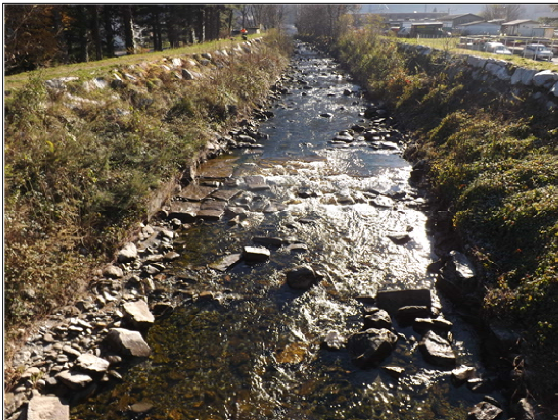
Figura 2-77: il tratto di rilievo a valle della centrale con portata 0,14 m 3 /s
