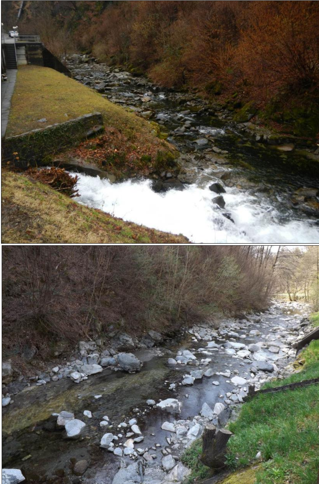
Figura 1-11: il tratto MOR-TR4 presso la centrale AMB
