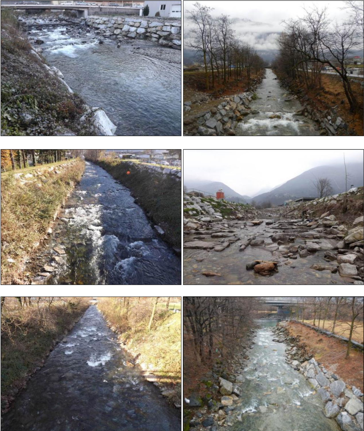
Figura 1-18: il tratto MOR-TR7 tra il ponte di via Monte Ceneri e la foce della Morobbia
