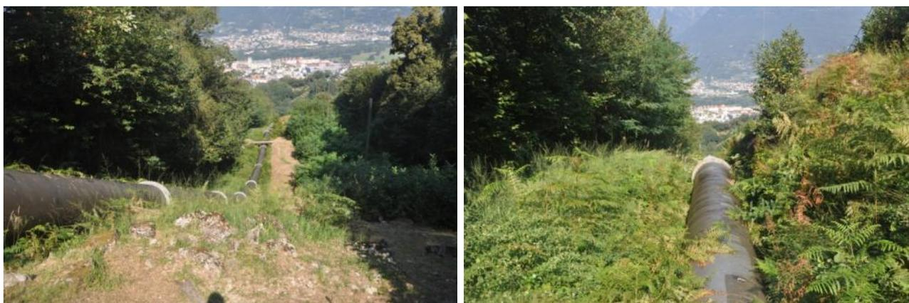
Figura 5-13: condotta forzata a cielo aperto (© EcoControl SA).
