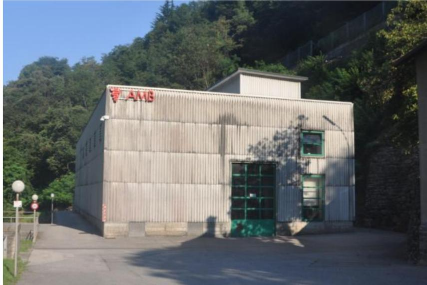
Figura 6-4: situazione attuale della struttura della centrale idroelettrica di Giubiasco, interamente rivestita con pannelli in Eternit.
