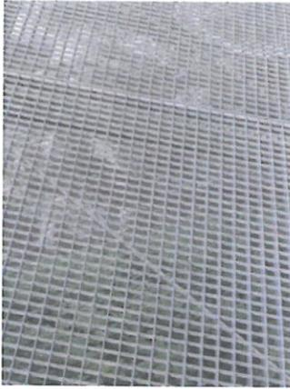
2- Il pavimento é composto da griglie in metallo. In caso di pioggia o umidità (soprattutto in inverno), la superficie risulta molto scivolosa. Per un ciclista in caso di frenata o cambiamento di traiettoria la caduta é dietro l'angolo. Posso anche immaginare le ferite che potrebbero causare le griglie in caso di caduta (tagli alla cute, rottura delle dita se entrano nei buchi, ...). Non da ultimo le griglie ne rendono pure difficoltoso l'attraversamento a cani di piccola o media taglia.
