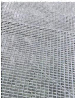
2- Il pavimento è composto da griglie in metallo. In caso di pioggia o umidità (soprattutto in inverno), la superficie risulta molto scivolosa. Per un ciclista in caso di frenata o cambiamento di traiettoria la caduta è dietro l'angolo. Posso anche immaginare le ferite che potrebbero causare le griglie in caso di caduta (tagli alla cute, rottura delle dita se entrano nei buchi, ...). Non da ultimo le griglie ne rendono pure difficoltoso l'attraversamento a cani di piccola o media taglia.
