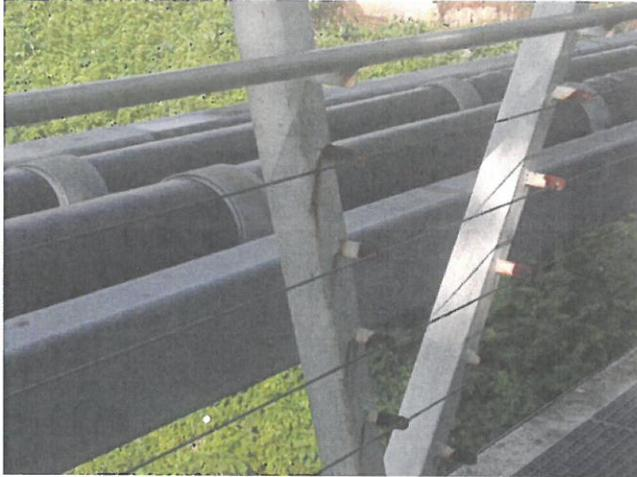
3- Una rovinosa caduta non sarebbe nemmeno protetta dalla struttura delle pareti laterali. Oltre ad un passamano in acciaio, le ringhiere laterali sono completate da funi metalliche sostenute da passafuni sporgenti in acciaio. Nel caso qualcuno dovesse rovinarvi addosso, il rischio di ferimento é davvero elevato, soprattutto contro questi passafuni.
