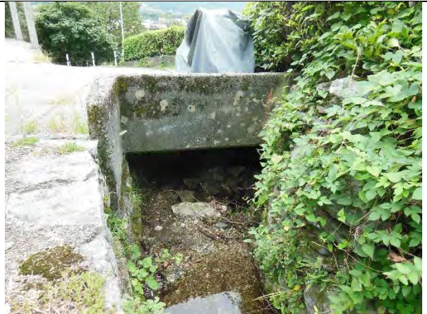
Lu_9.2 – LUSANICO_09 (imbocco tratto intubato)
