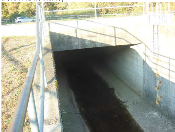
Gu_x3 (da monte verso valle) -- tratto non considerato (interno a SRA Fiume Ticino), ingresso tratto intubato finale
