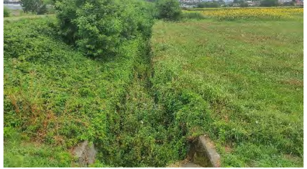
Sa_4.1 (da valle verso monte) - Tratto SALEGGI_04 non considerato perché artificiale (canale di gronda).
