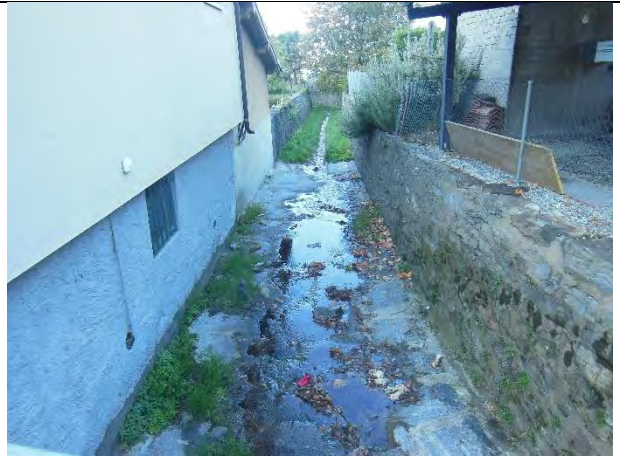
Gu_2.6 (da monte verso valle) -- GUASTA_02
