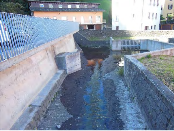
Da_3.9 (da monte verso valle) -- DARESE_03, confluenza con il riale Lobbia, camera di ritenuta a monte del tratto intubato.
