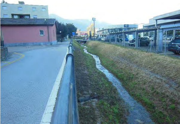
Gu_2.13 (da monte verso valle) -- GUASTA_02
