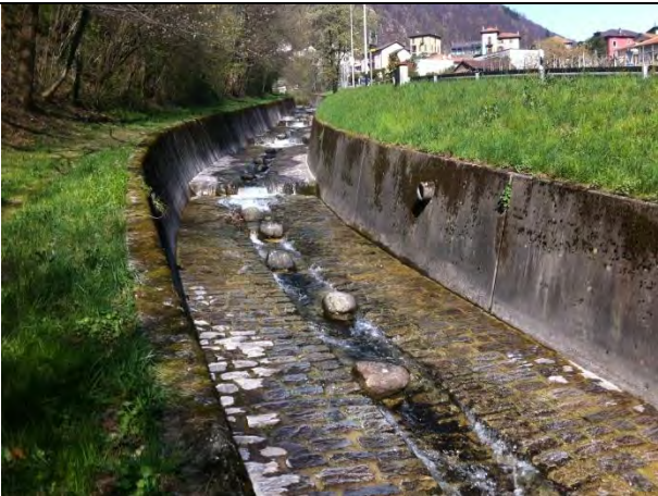
G_1.3 - Tratto 2 del rilievo ecomorfologico (R). Verso monte.
