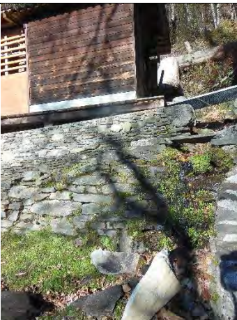
Dr_4.1 (da valle verso monte) -- DRAGONATO_04
