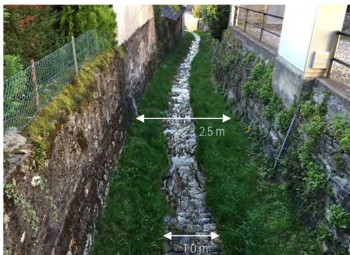
Fig. 14 Esempio di corso d'acqua artificiale (Riale Guasta) con distanza elevata tra i piedi di sponda. In casi come questo, l'applicazione dei fattori di correzione alla LFA riportata nel rilievo ecomorfologico livello R (basata sulla distanza tra i piedi di sponda, 2.5 m) porta a sovrastimare la LnFA. La misura dell'alveo privo di vegetazione (1.0 m) porta invece ad ottenere valori analoghi alla LnFA misurata presso un tratto naturale a monte (LnFA = 2 m).
