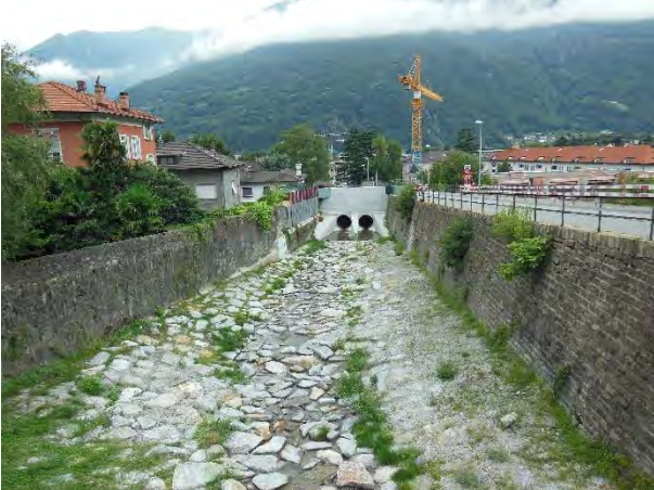
Dr_3.11 (da monte verso valle) -- DRAGONATO_03, a monte del tratto intubato provvisorio (lavori linea ferroviaria)
