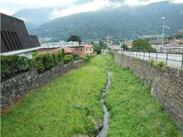
Dr_3.9 (da monte verso valle) -- DRAGONATO_03
