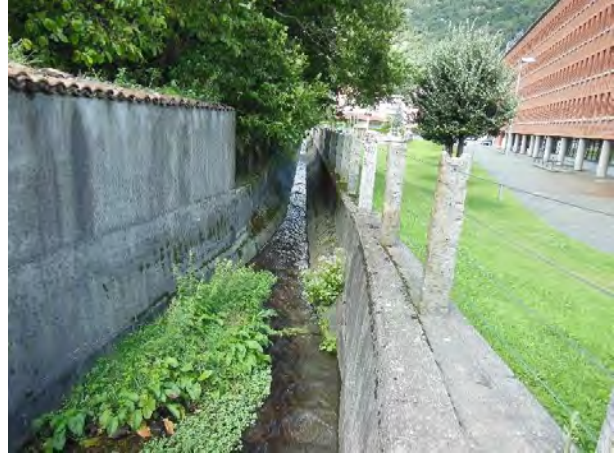
Dr_2.7 (da monte verso valle) -- DRAGONATO_02
