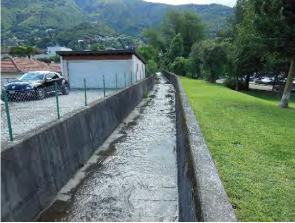
Dr_2.6 (da valle verso monte) -- DRAGONATO_02
