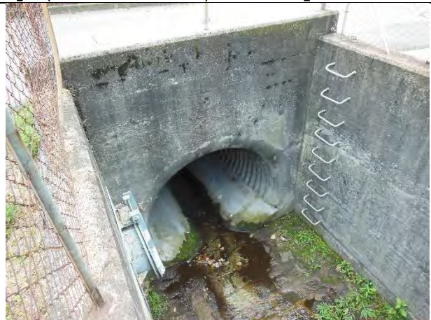
V_1.6 (imbocco tratto intubato) - VIGNORA_01
