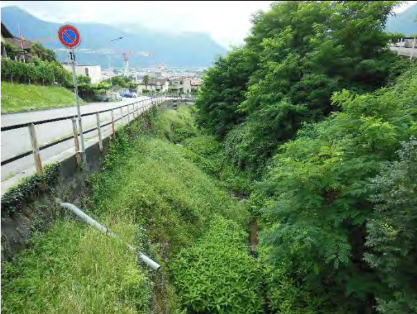
Dr_3.3 (da monte verso valle) -- DRAGONATO_03, tratto a valle dell'attraversamento di via Sasso Corbaro
