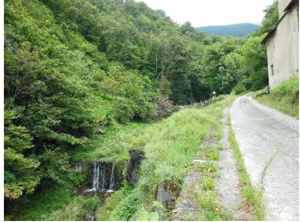
Dr_3.2 (da valle verso monte) -- DRAGONATO_03
