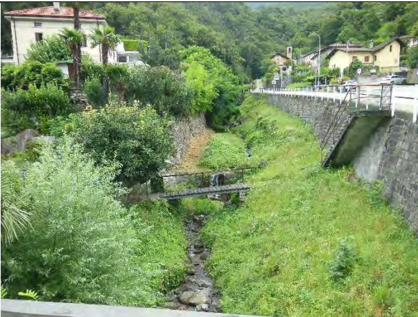
Dr_3.5 (da valle verso monte) -- DRAGONATO_03
