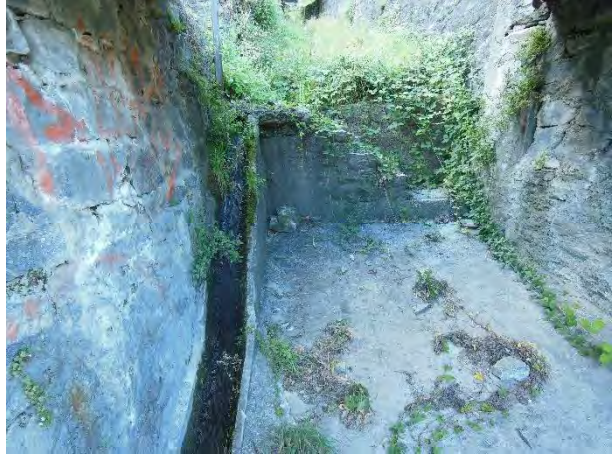
Be_3.4 (dettaglio canaletta di magra) - BERTALLO_03
