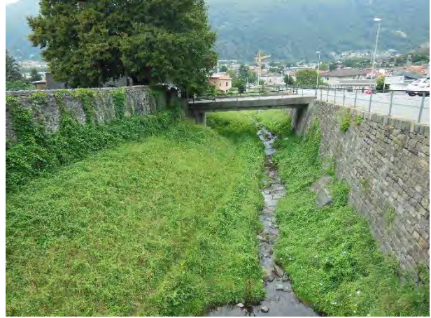
Dr_3.8 (da monte verso valle) -- DRAGONATO_03
