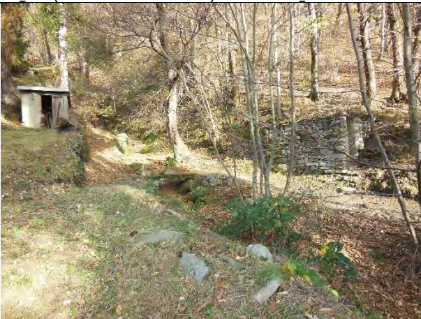
Lo_x3 (da valle verso monte) -- Tratto subito a monte del segmento LOBBIA_03
