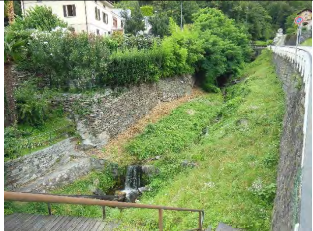
Dr_3.4 (da valle verso monte) -- DRAGONATO_03
