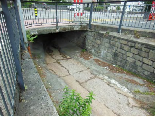
Dr_3.13 (da monte verso valle) -- DRAGONATO_03, sottopasso di via Lugano
