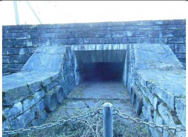
Vv_3.8 -- VALLONE-VARESCA_03 (imbocco sottopasso ferroviario)
