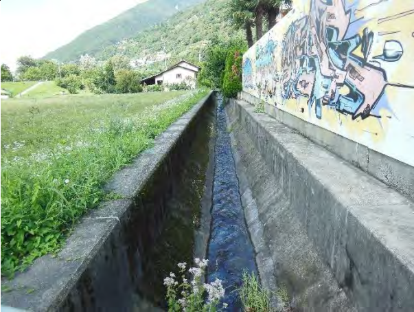
Dr_2.8 (da monte verso valle) -- DRAGONATO_02
