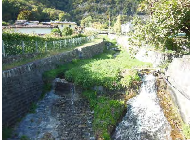
Ri_2.5 (da valle verso monte) - RIGHETTI_02 (tratto subito a monte di via Birreria)
