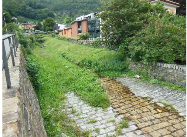
Dr_3.10 (da valle verso monte) -- DRAGONATO_03
