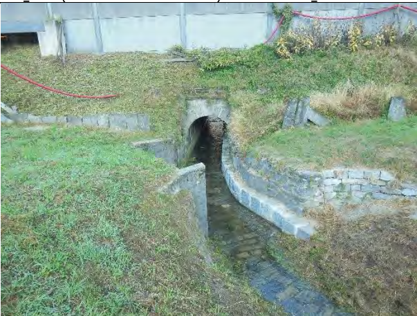
Gu_2.15 (da monte verso valle) -- GUASTA_02, imbocco sottopasso ferrovia
