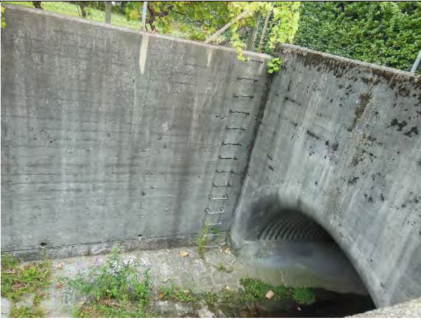
Lu_1.4 (imbocco tratto intubato) - LUSANICO_01
