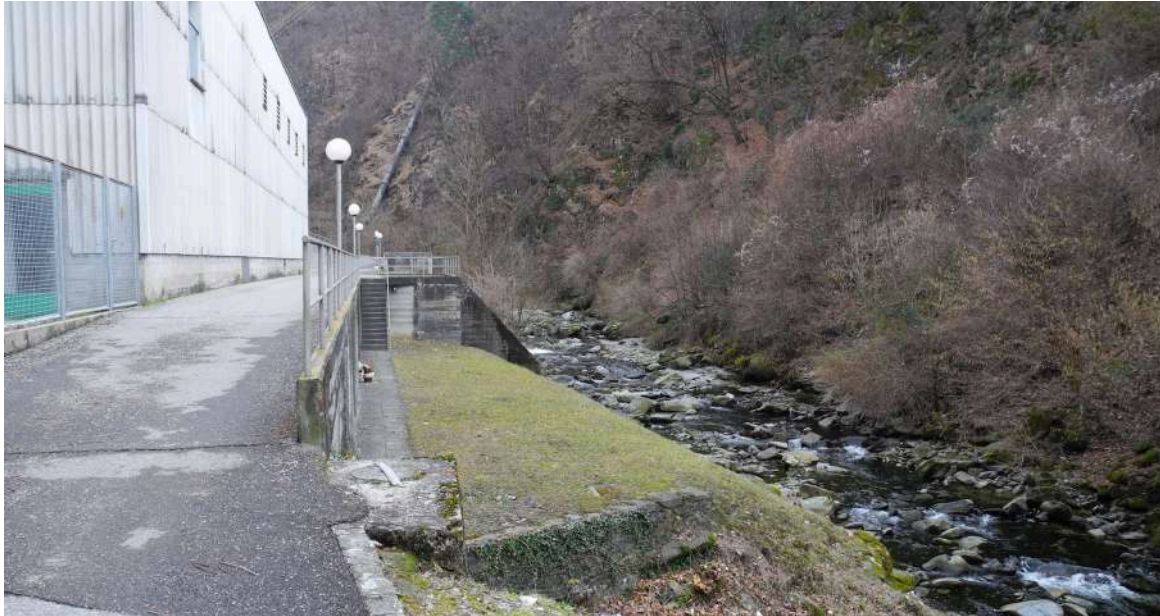
Torrente Morobbia all'altezza della Centrale Morobbia.
