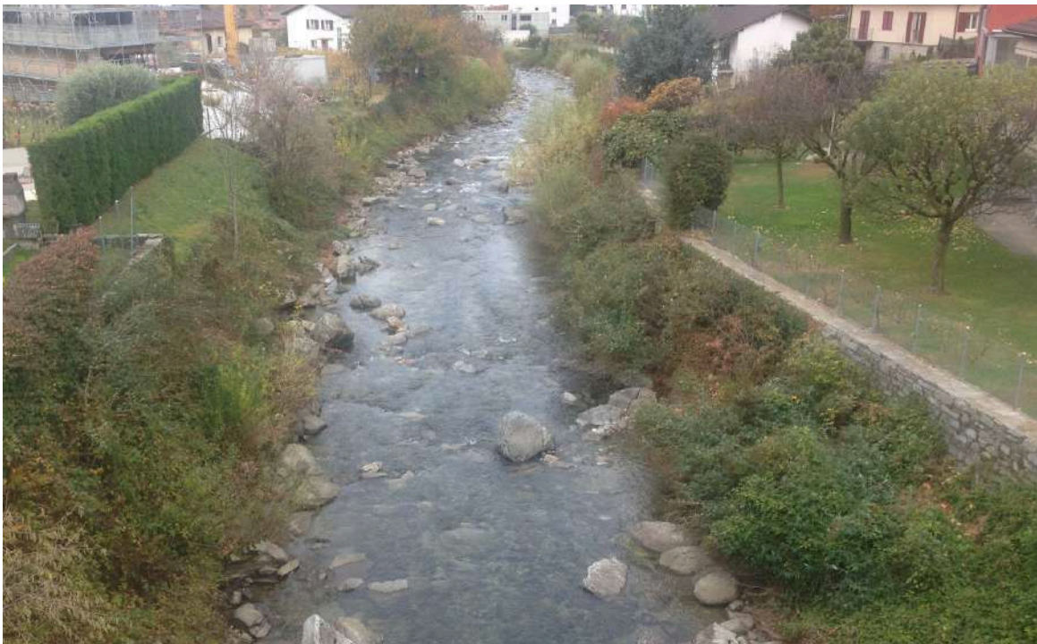
Torrente Morobbia a valle del Ponte Vecchio.
