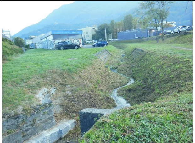
Gu_2.14 (da valle verso monte) -- GUASTA_02
