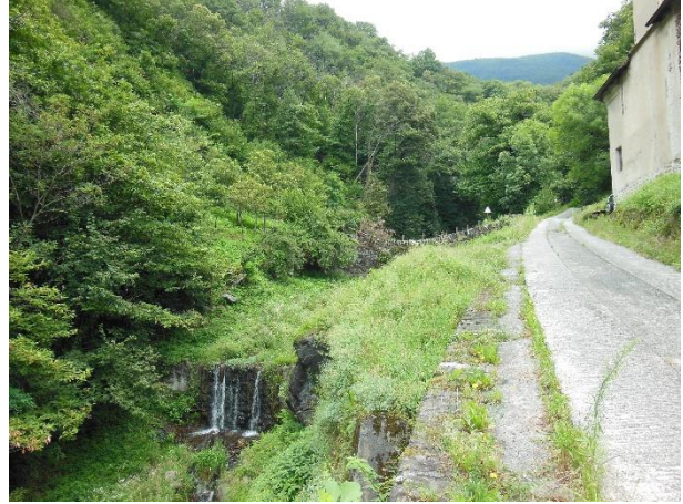
Dr_3.2 (da valle verso monte) -- DRAGONATO_03
