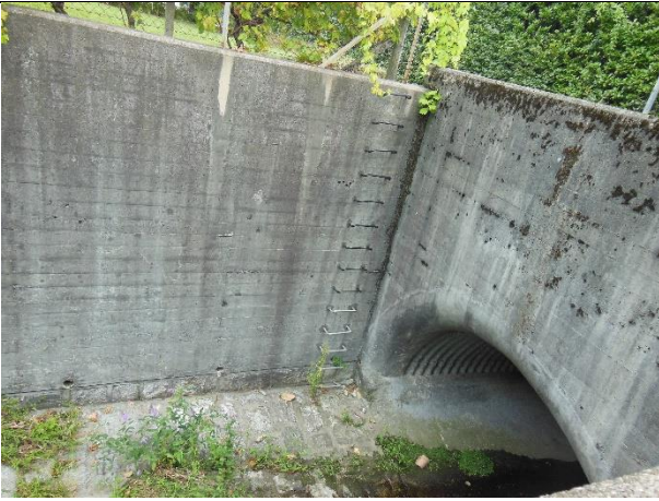
Lu_1.4 (imbocco tratto intubato) - LUSANICO_01
