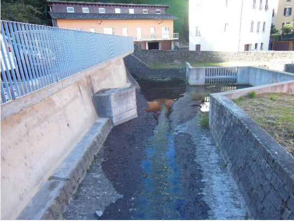
Da_3.9 (da monte verso valle) -- DARESE_03, confluenza con il riale Lobbia, camera di ritenuta a monte del tratto intubato.
