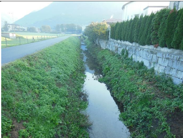
Gu_1.2 (da valle verso monte) -- GUASTA_01
