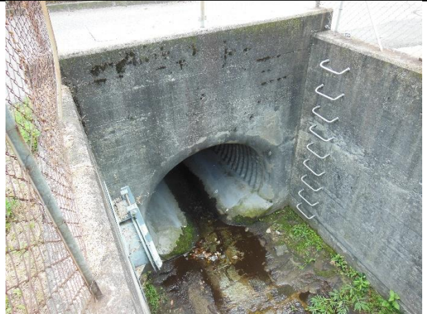
V_1.6 (imbocco tratto intubato) - VIGNORA_01
