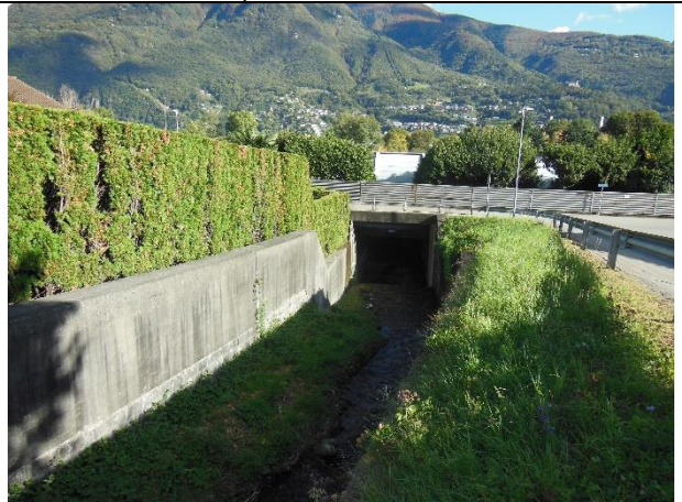
Ri_1.2 (da monte verso valle) - RIGHETTI_01 (imbocco tratto intubato)
