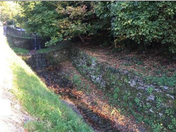
Gu_2.1 (da valle verso monte) -- GUASTA_02
