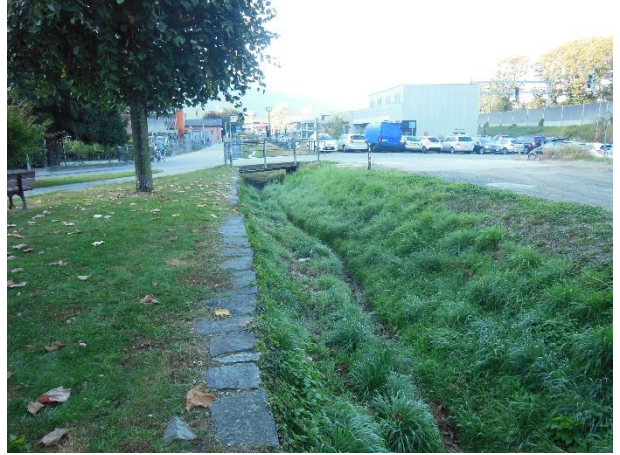
Gu_2.12 (da monte verso valle) -- GUASTA_02
