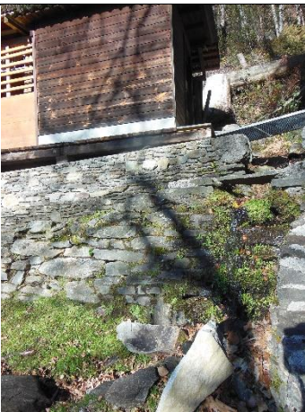
Dr_4.1 (da valle verso monte) -- DRAGONATO_04
