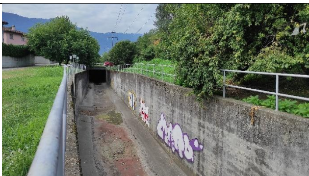
Sa_x (da monte verso valle) - Tratto SALEGGI_00A non considerato perché artificiale (canale di gronda).
