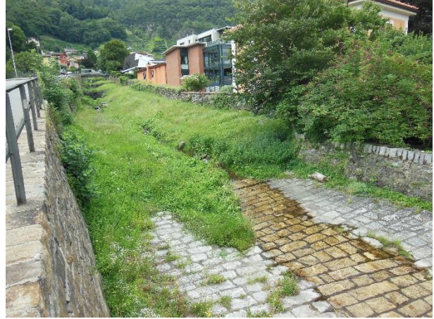
Dr_3.10 (da valle verso monte) -- DRAGONATO_03
