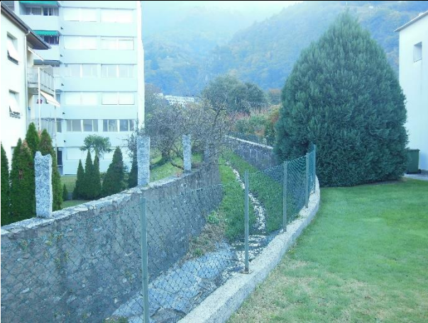
Gu_2.7 (da valle verso monte) -- GUASTA_02
