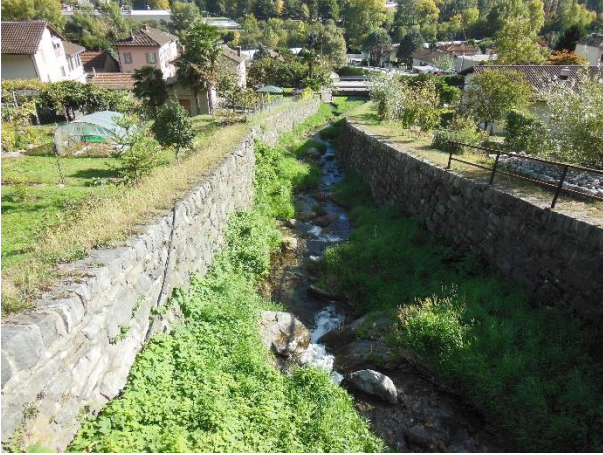
Ri_2.4 (da monte verso valle) - RIGHETTI_02 (tra ponte di via Mezzavilla e ponte di via Birreria)
