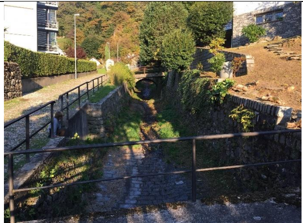
Gu_2.2 (da valle verso monte) -- GUASTA_02
