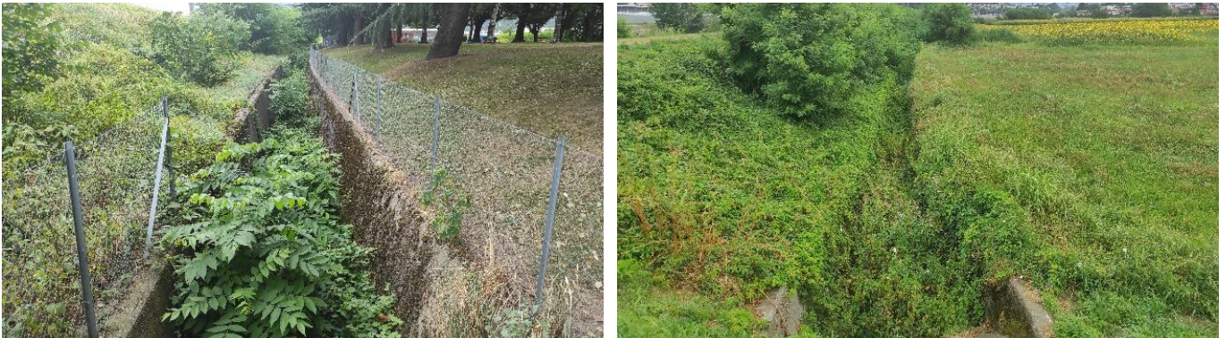
Fig. 8 Stato del canale a monte delle piscine (segmento SALEGGI_04). A sinistra foto scattata in corrispondenza della casa anziani Greina (parcella 450 RFD di Bellinzona). A destra foto scattata all'altezza della piazza di giro su Viale Giuseppe Motta (parcella 598 RFD di Bellinzona).
