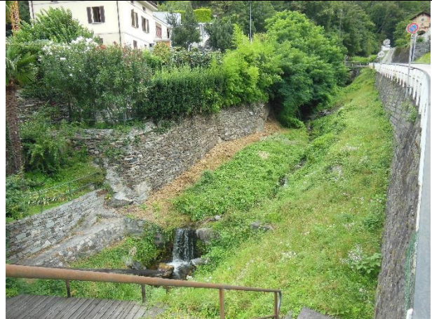
Dr_3.4 (da valle verso monte) -- DRAGONATO_03
