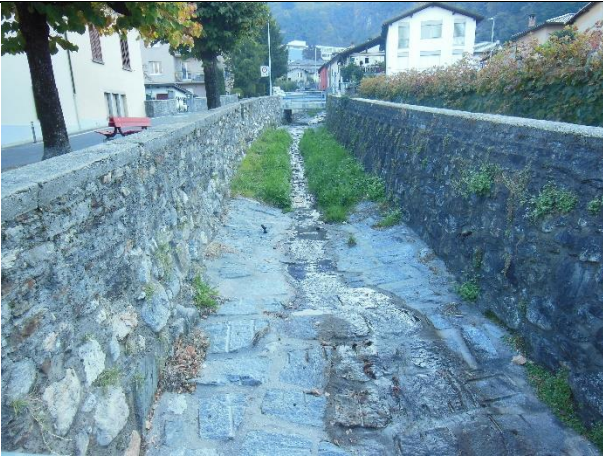
Gu_2.5 (da valle verso monte) -- GUASTA_02
