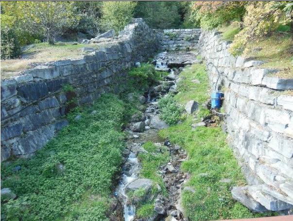
Ri_2.2 (da valle verso monte) – RIGHETTI_02 (tratto tra la briglia in blocchi e la passerella pedonale)
