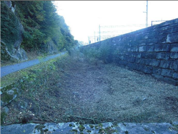
Vv_3.7 (da valle verso monte) -- VALLONE-VARESCA_03 (tratto subito a monte del sottopasso ferroviario)
