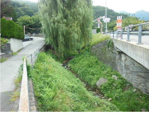
Dr_3.7 (da valle verso monte) -- DRAGONATO_03, a monte dell'attraversamento di via Ospedale
