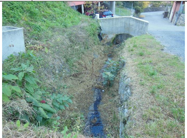
Rg_4.4 (da monte verso valle) -- RIGANELLA_06, a monte dell'imbocco del tratto intubato RIGANELLA_05
