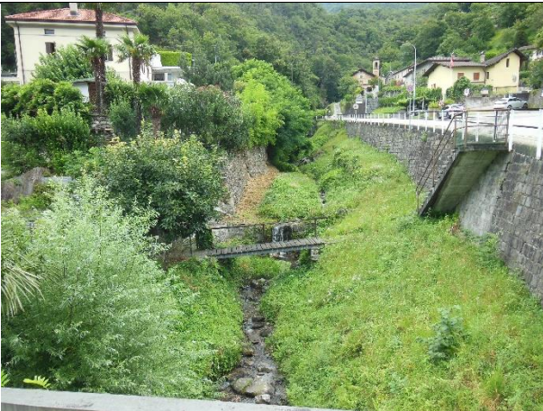
Dr_3.5 (da valle verso monte) -- DRAGONATO_03
