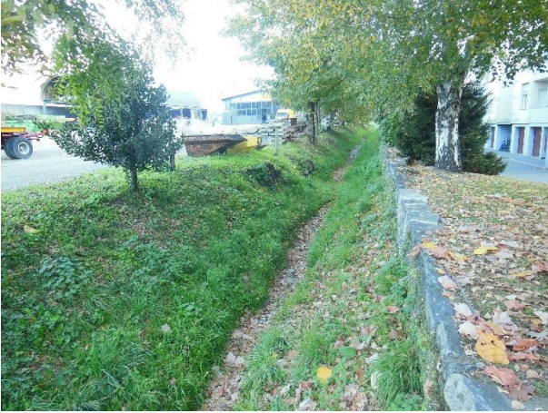
Gu_2.11 (da valle verso monte) -- GUASTA_02
