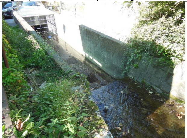
Bo_3.12 (da monte verso valle) -- BONE'_03, a monte dell'imbocco del tratto intubato di via Carrale Boné
