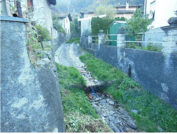
Gu_2.3 (da valle verso monte) -- GUASTA_02
