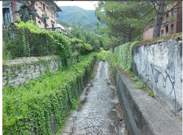
Dr_2.3 (da valle verso monte) -- DRAGONATO_02, tratto subito a monte di via Ghiringhelli
