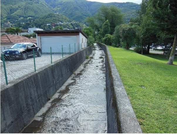
Dr_2.6 (da valle verso monte) -- DRAGONATO_02
