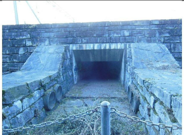
Vv_3.8 -- VALLONE-VARESCA_03 (imbocco sottopasso ferroviario)
