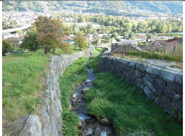
Ri_2.3 (da monte verso valle) – RIGHETTI_02 (tratto tra passerella pedonale e ponte di via Mezzavilla)
