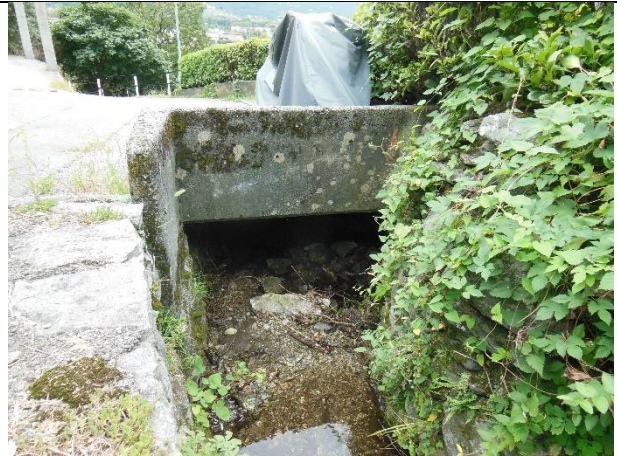
Lu_9.2 – LUSANICO_09 (imbocco tratto intubato)
