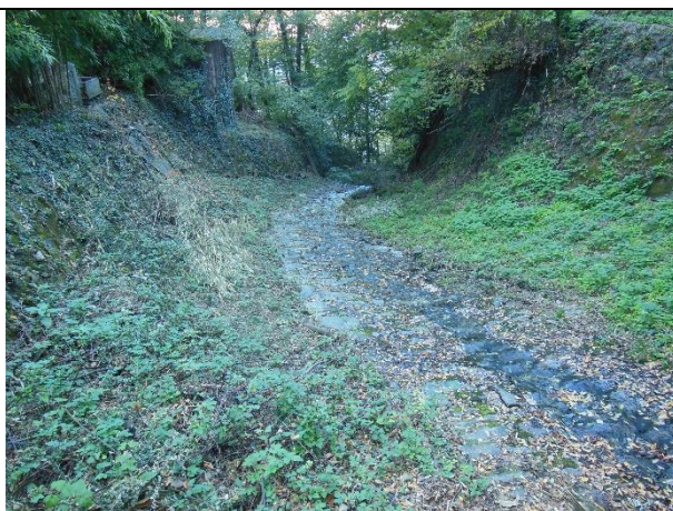
Vv_3.2 (da monte verso valle) -- VALLONE-VARESCA_03 (Tratto a valle della passerella pedonale)
