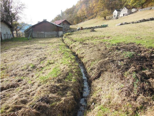
Lu_x1 (da valle verso monte) – Drenaggio (tratto non considerato)
