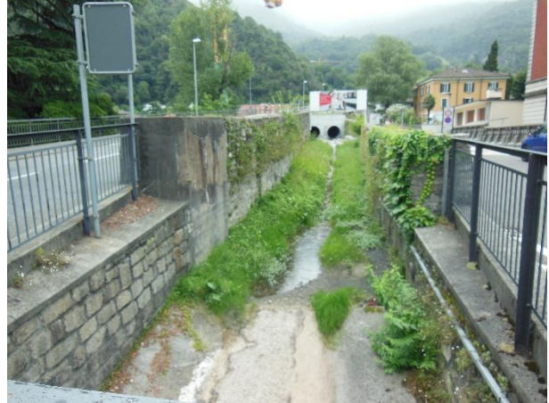
Dr_3.12 (da valle verso monte) -- DRAGONATO_03, tra il tratto intubato provvisorio (lavori linea ferroviaria) e via Lugano
