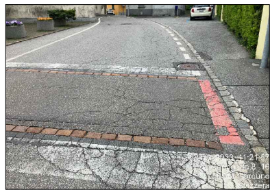
FOTO 2: vista verso via Cantone
