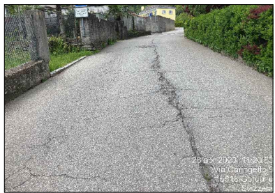
FOTO 1: vista verso via Cantone
