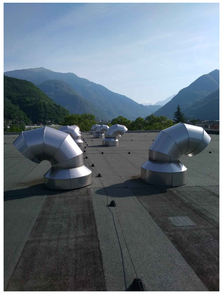
Lato nord - conversa, troppipieno e piletta esistenti
