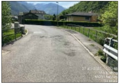
FOTO 3: vista verso via ala Réssighe
