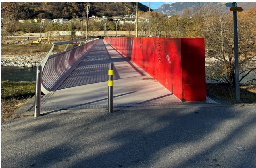
Figura 4 – Accesso alla passerella da Pratocarasso
