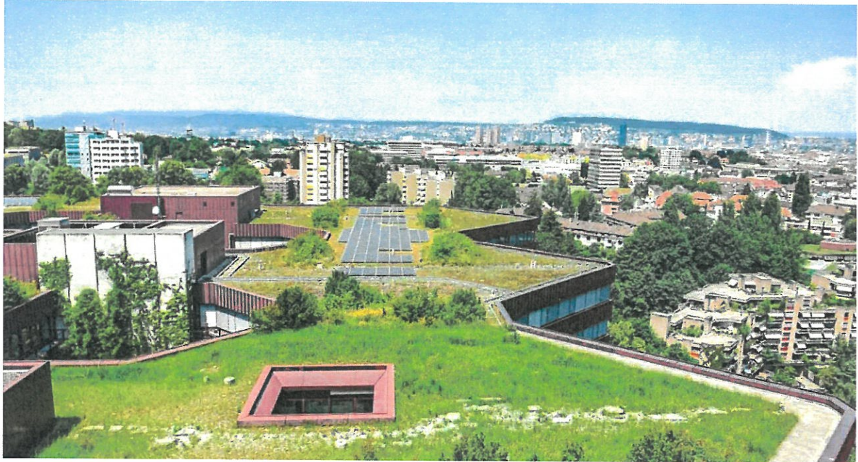
Biotopi alternativi, energia solare e spazi aperti: i paesaggi sui tetti offrono possibilità inimmaginabili (Credit Suisse Uetliberg). © Grün Stadt Zürich
