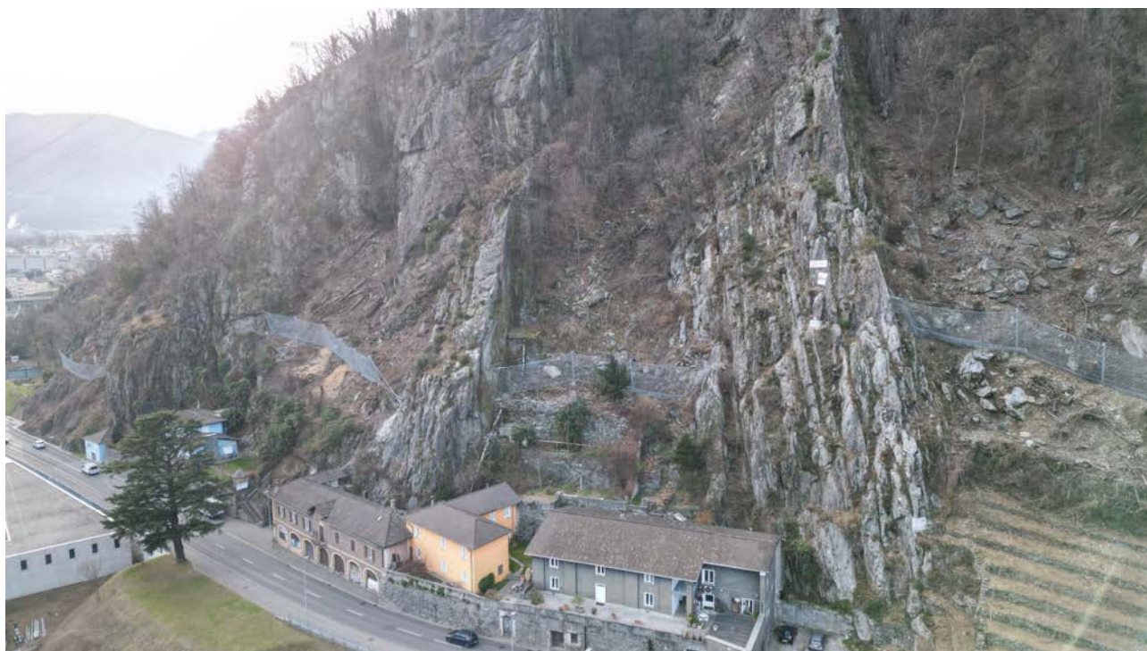
Foto 2: panoramica opere di protezione tra i mappali no. 3521 e 6343
