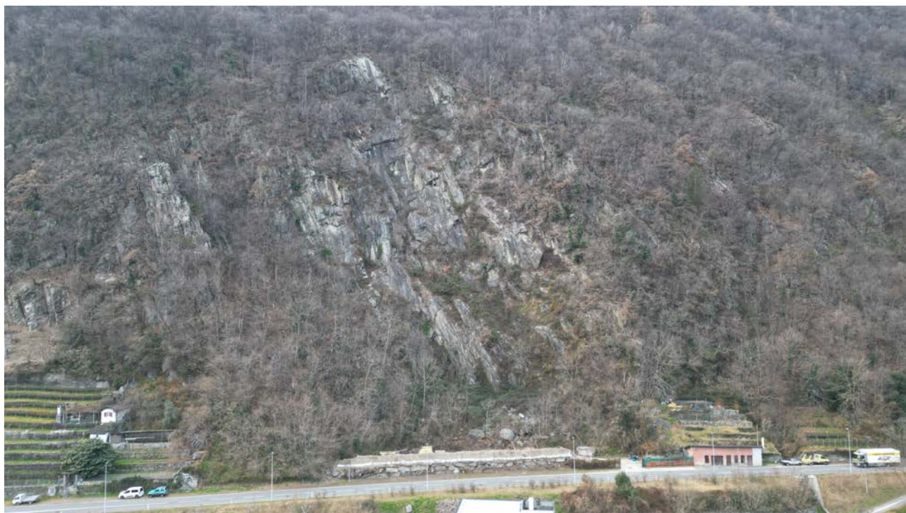
Foto 4: panoramica vallo di contenimento rinforzato a protezione della strada cantonale
